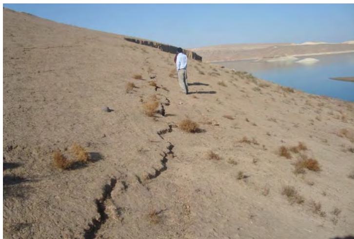
شکل (۷) ترک های ایجاد شده در قبل از گسیختگی
