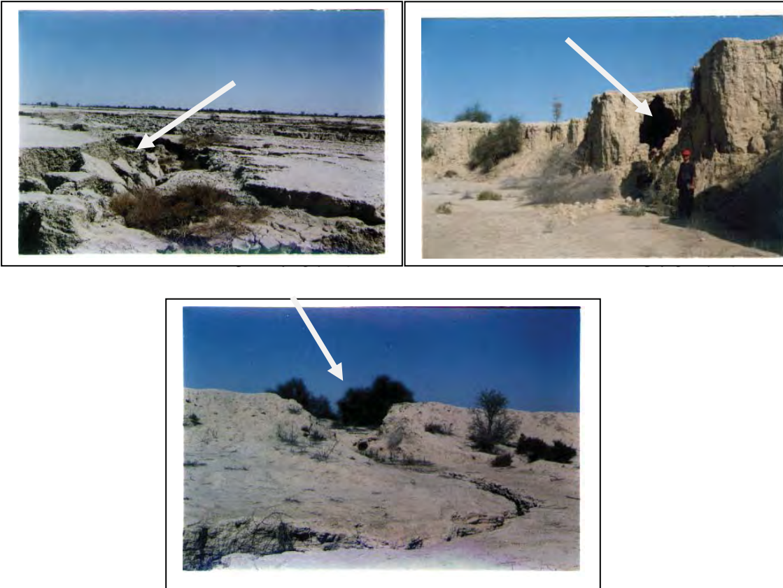
شکل ۳ ایجاد شیارهای عمیق در خروجی سامانه دگار
