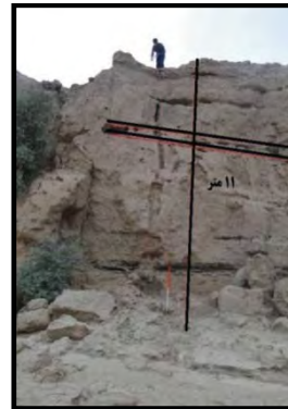
شکل شماره ۱۰: عمیق شدگی بستر رودخانه ملک آباد
