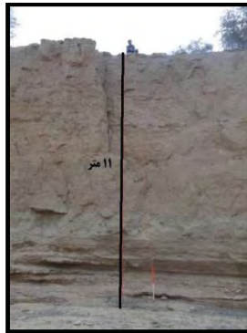
شکل شماره ۱۱: عمیق شدگی بستر رودخانه ملک آباد
