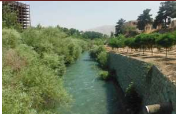
شکل ۷) احداث دیواره های سنگی و سیمانی و نفوذناپذیر در امتداد رودخانه، قبل از پل شاه عباسی
