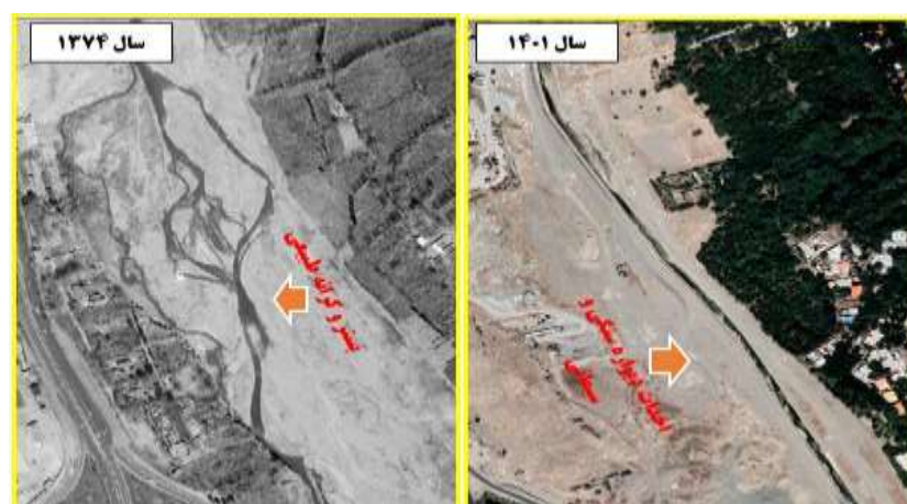
شکل ۵) نمایی از احداث دیواره سنگی و سیمانی و تغییر الگوی رودخانه، بازه شماره ۵، پایین دست پارک چمران
