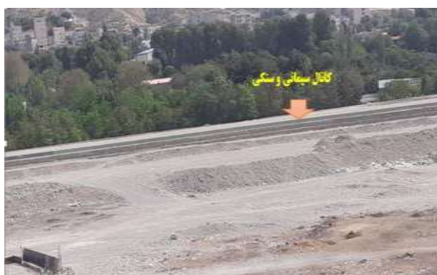
شکل ۹) نمایی از بستر کانالیزه شده با مصالح سیمانی و سنگی و نفوذناپذیر در محدوده بین پارک چمران تا پل بزرگراه تهران- کرج
