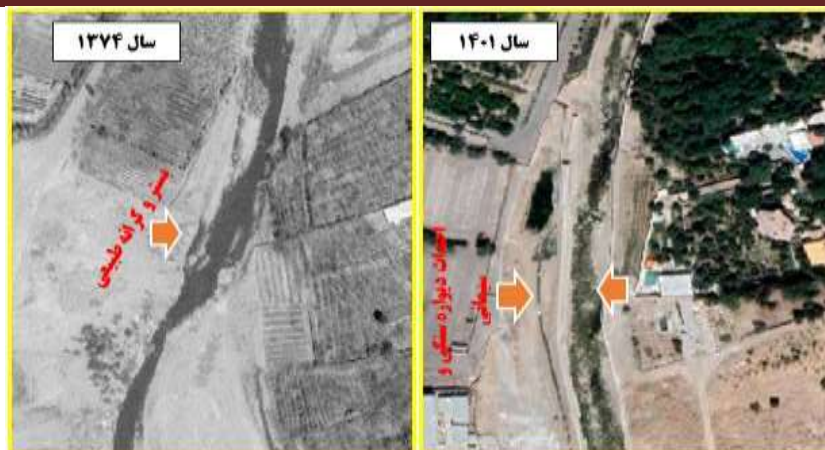
شکل ۴) نمایی از احداث دیواره سنگی و سیمانی در امتداد مجرای رودخانه، بازه شماره ۴ محدوده پارک چمران
