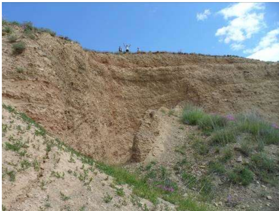
شکل ۸: نمایی از زمین لغزش قزل درخ
