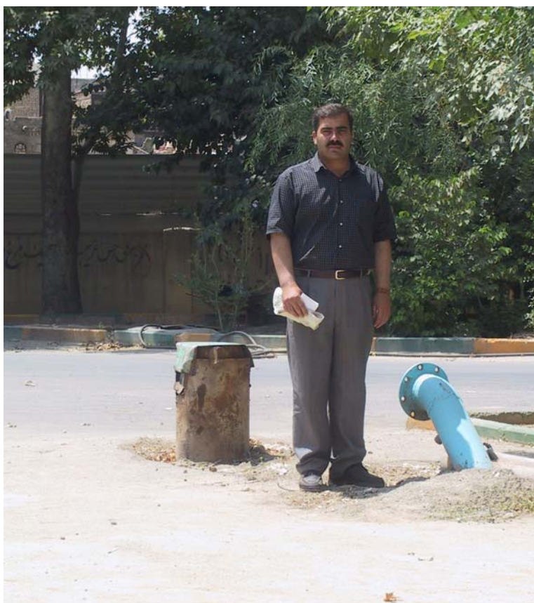
نگاره ۲-۲- اثر فرونشست زمین در منطقه احمد آباد مستوفی به صورت پدیده رشد لوله جدار چاه
